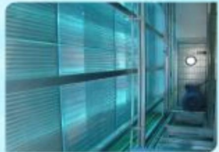
Теплообменник, очищенный с помощью модуля Steril-Aire
